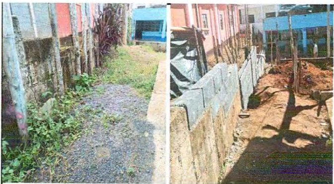
Foto 3: Sustitución de cerco o muro perimetral.
