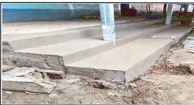
Foto 5: Reparación de piso en área de corredor 2
