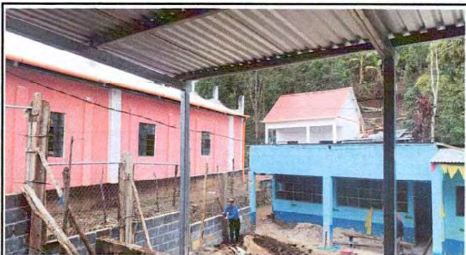
Foto 3: Sustitución de cerco o muro perimetral.
