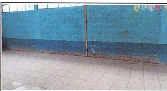
Foto 6: Mejoramiento y cambio de piso en las aulas
