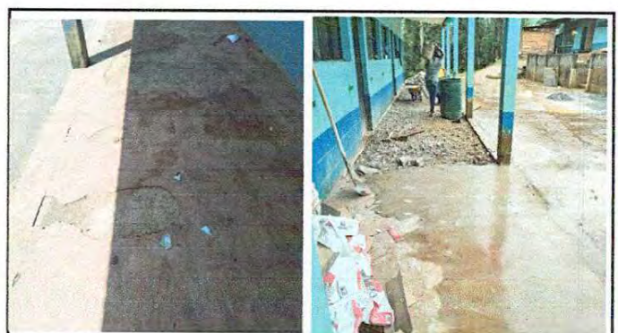
Foto 4: Mejoramiento y cambio de piso corredor 1
