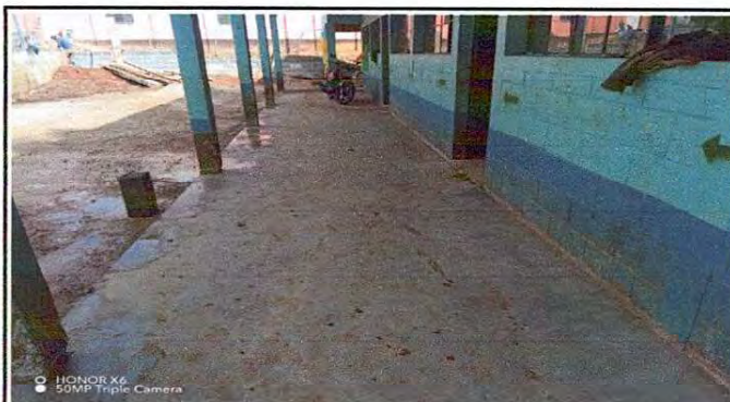
Foto 4: Mejoramiento y cambio de piso corredor 1
